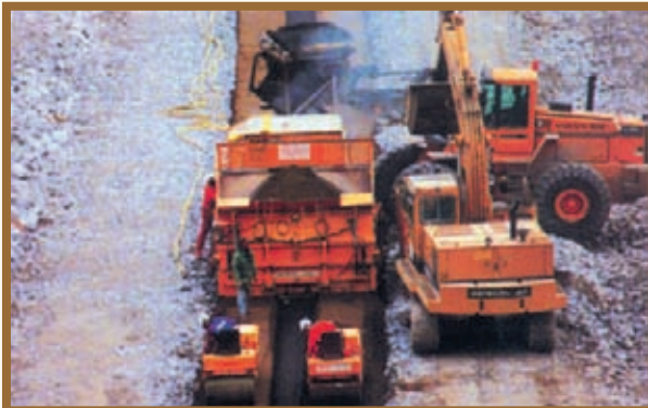
A colocação de máquinas em operação
